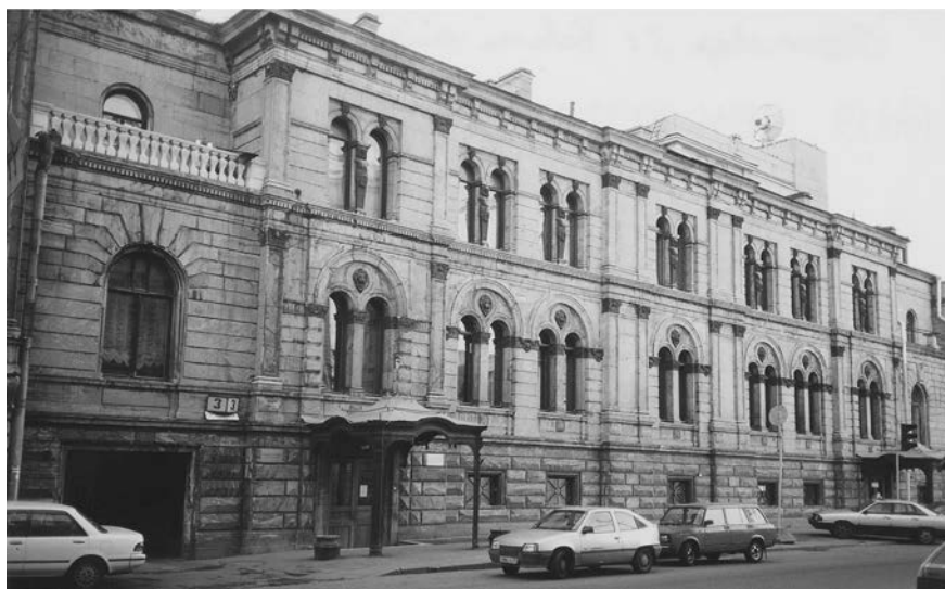
Здание бывшего Управления по сооружению Мурманской ж.д. на Гагаринской улице в Санкт-Петербурге
